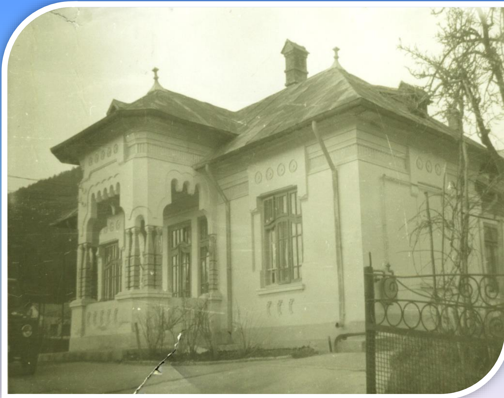
Clădirea instituției la anul 1920
